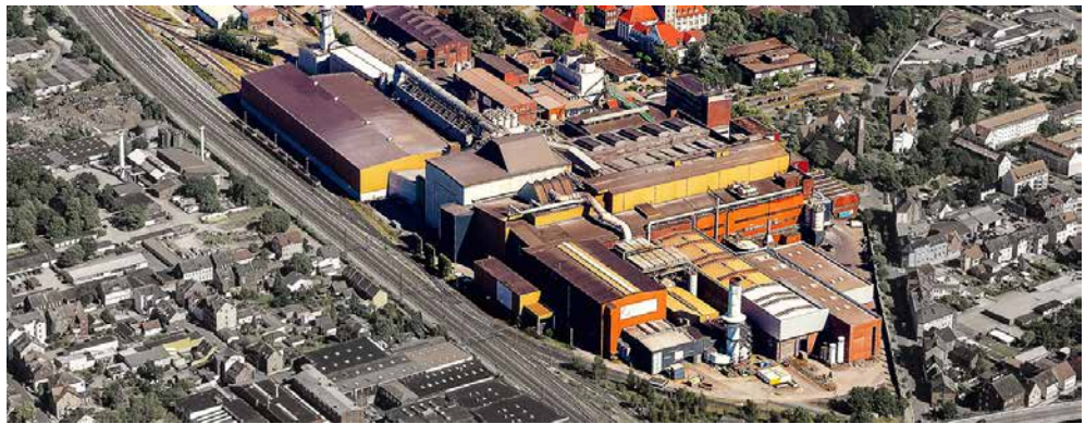
Peiner Träger GmbH plant site.
